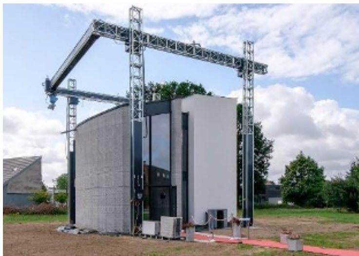
11 pav.: Namų konstrukcijos spausdinimas 3D spausdintuvu
